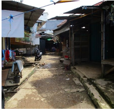
Contoh Kondisi Jalan yang Tidak Dilengkapi Saluran Drainase
