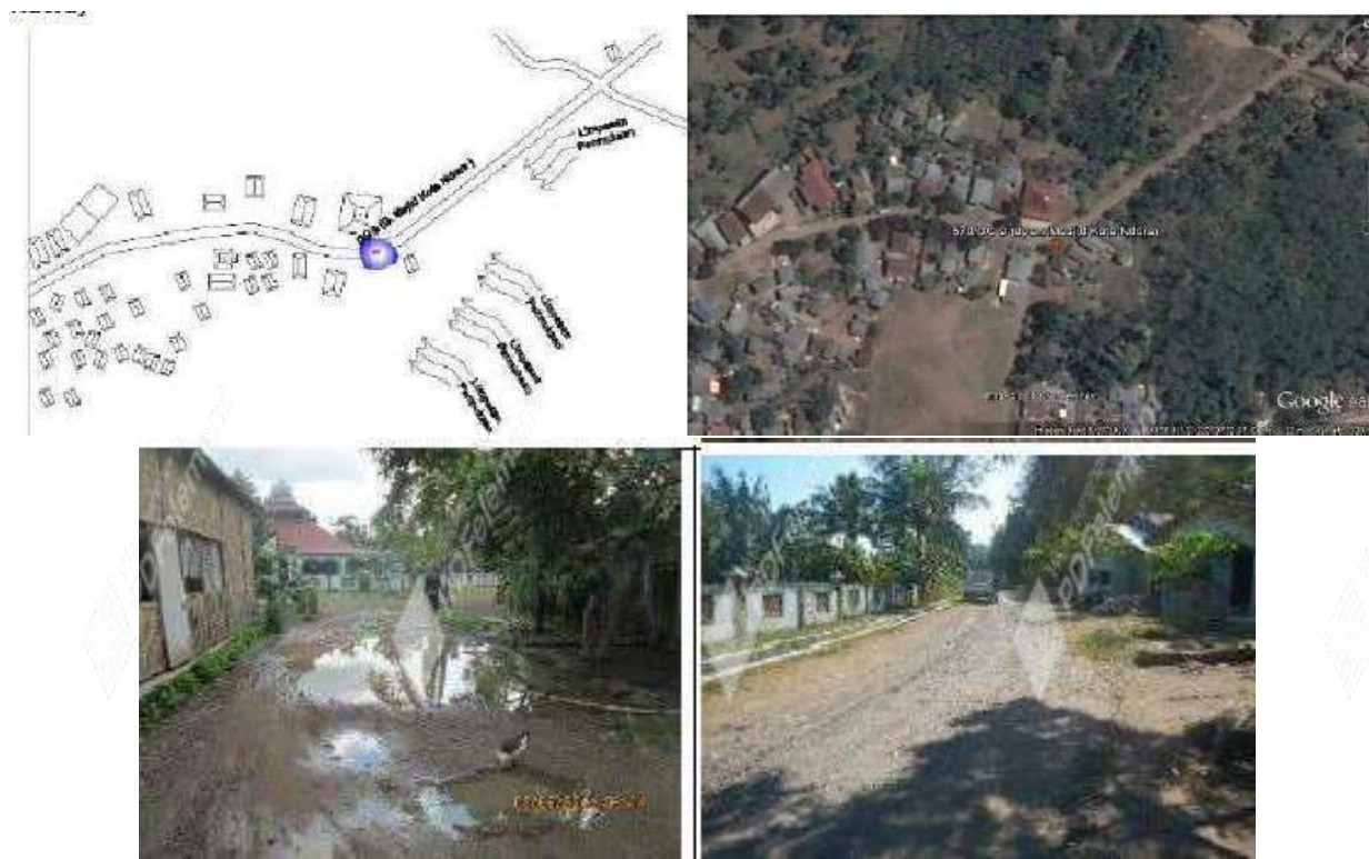
Gambar 3. 17 Dokumentasi Identifikasi daerah genangan di DG 9 (Jl. Srikaya Masjid)
