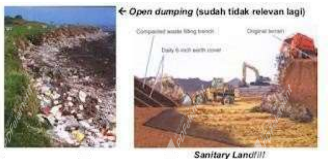
Gambar 2. 56 Perbedaan Open Dumping dan Sanitary Landfill
