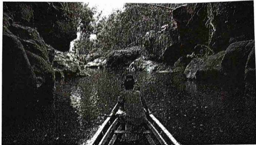
Gambar 4.81. Kondisi dan Letak Tebing Sungai Kopu
