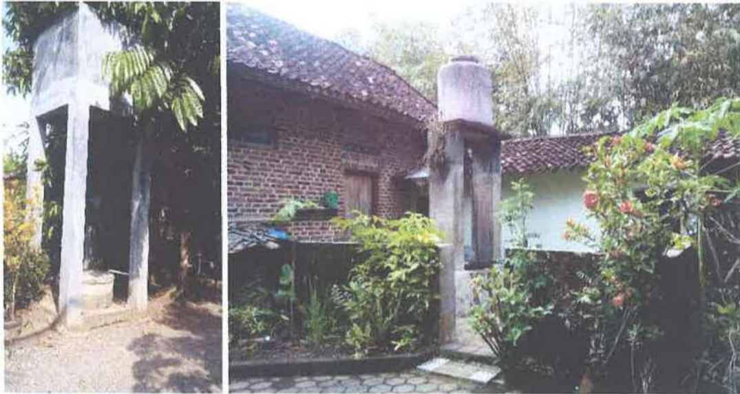
Gambar 3-35 Kondisi Sumur dengan Bak Tandon Pasangan Bata
