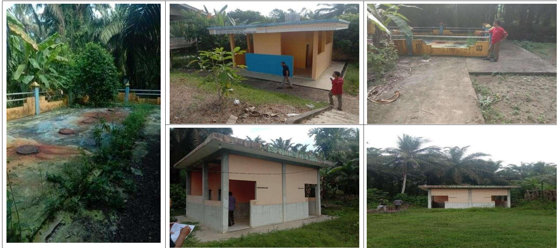
Gambar 2.14 Dokumentasi IPALD di Kab. Rokan Hulu
