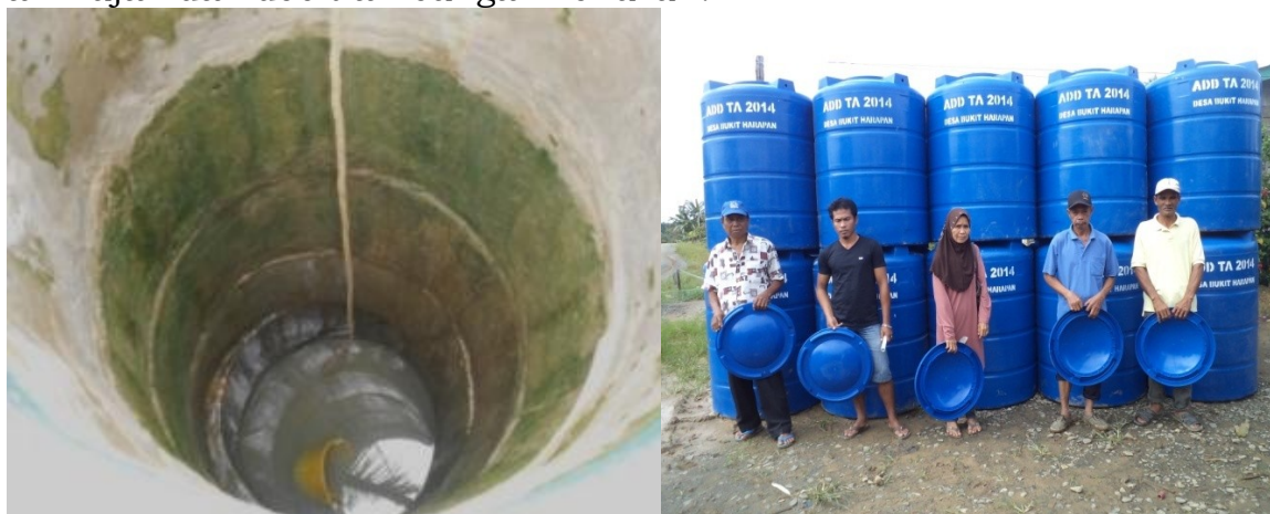
Gambar II-17 Kondisi Sumur Bor Desa Sungai Limau (Kiri) dan Profil Tank Program PNPM Desa Bukit Harapan (Kanan) Kawasan Perdesaan Perkebunan di Perbatasan Negara Sumber: Dokumentasi Desa Sungai Limau dan Bukit Harapan
