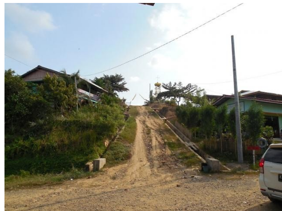
Gambar III-1 Jalan Agregat di Perbatasan Desa Sungai Limau (kiri) dan Jalan Tanah di Desa Sungai Limau (kanan)
