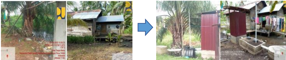
Gambar 3. 19 Pembangunan Sanitasi Sebelum (kiri) dan Sesudah (kanan)
