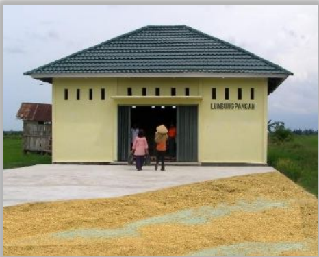
Salah satu bangunan lumbung pangan
