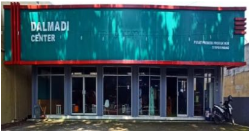
Gedung Dalmadi Center
