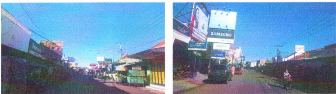
Gambar Kondisi Keandalan Bangunan di Perkotaan Ciledug
