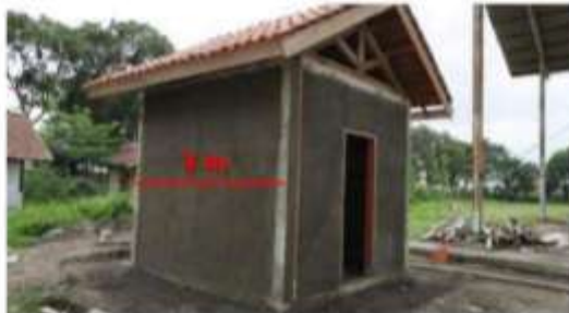
Gambar II.401 Luas Maksimum Dinding dan Jarak Maksimum Antar Kolom
