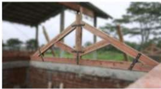
Gambar II.387 Kuda-kuda Kayu Dengan Pengikat Plat Baja
