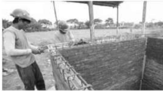
Tulangan balok keliling/ring dirangkai di atas dinding
