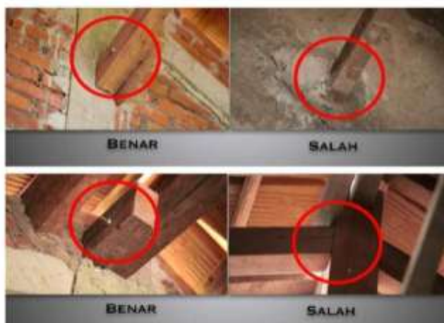
Gambar II.397 Contoh Detail Pertemuan Antara Ikatan Angin dengan Gunung-Gunung/ Ampig
