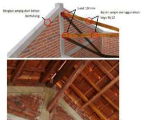
Gambar II.396 Pertemuan Antara Ikatan dengan Gunung-Gunung/ Ampig
