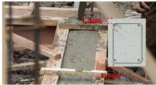
Gambar II.378 Balok Pengikat/ Sloof
