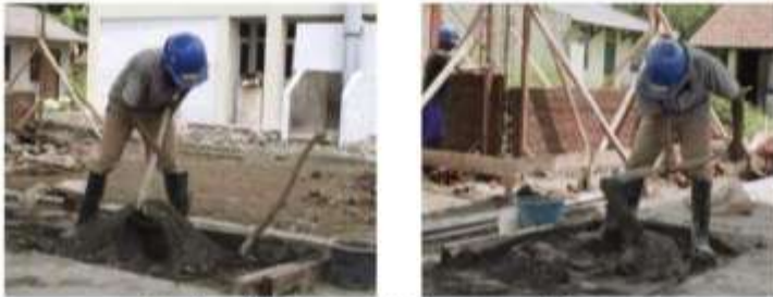
Gambar II.367 Proses Pencampuran Mortar
