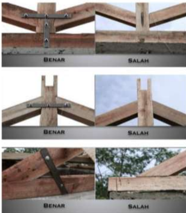
Gambar II.388 Pemasangan Plat Baja Pada Kuda-kuda Kayu
