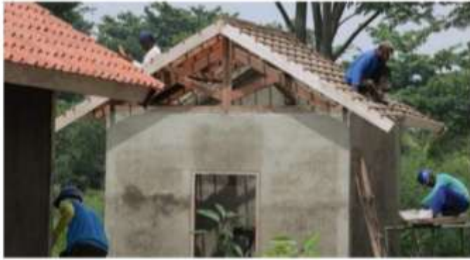
Gambar II.386 Kuda-kuda Kayu Pada Atap Rumah Tinggal
