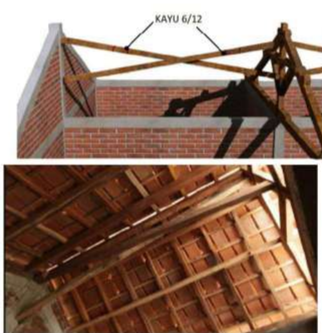
Gambar II.395 Ikatan Angin Antara Kuda-Kuda Kayu dengan Gunung-Gunung/ Ampig
