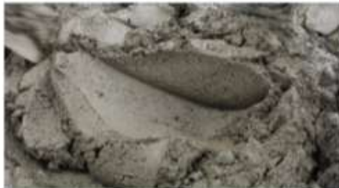
Gambar II.368 Hasil Pencampuran Mortar Yang Baik
