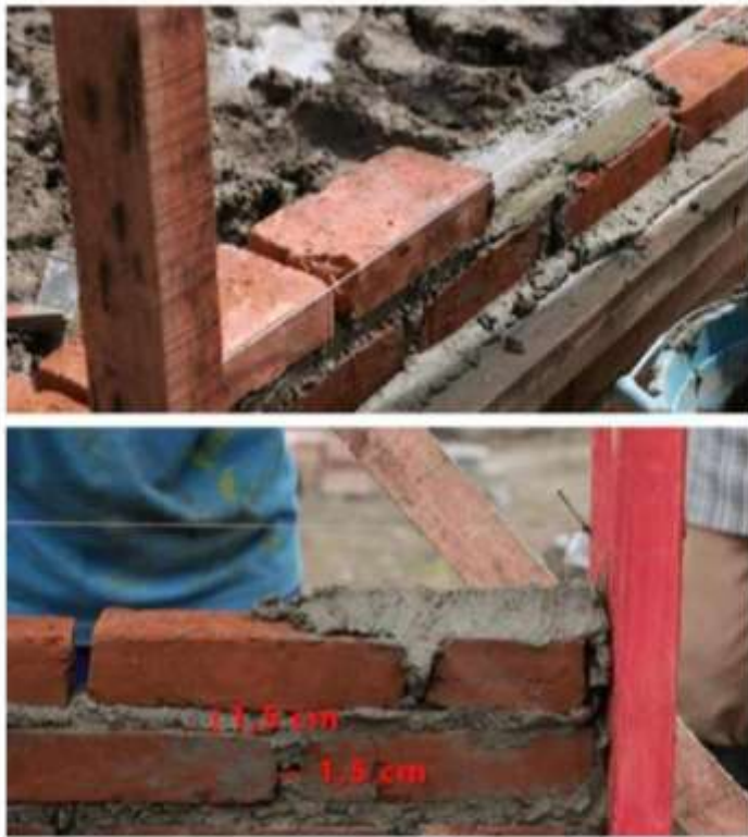
Gambar II.400 Proses Pemasangan Batu Bata Untuk Dinding
