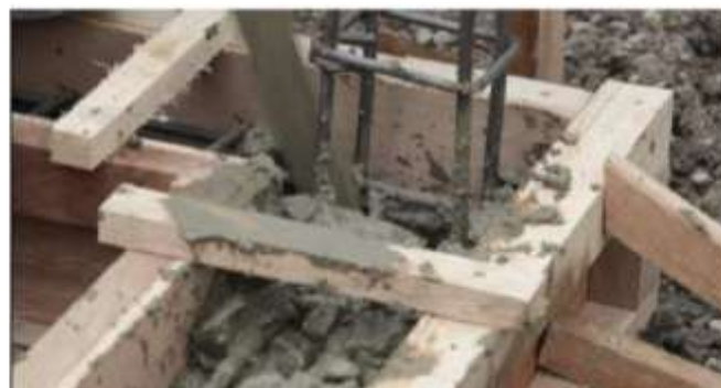
Gambar II.418 Pengecoran Balok Pengikat/ Sloof
