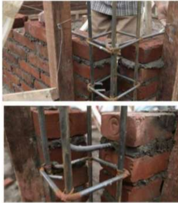
Gambar II.406 Pemasangan Angkur Besi Sebagai Pengikat Antara Kolom dengan Dinding Pada Sudut Bangunan
