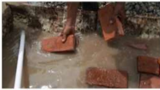
Gambar II.374 Perendaman Batu Bata Sebelum Dipasang
