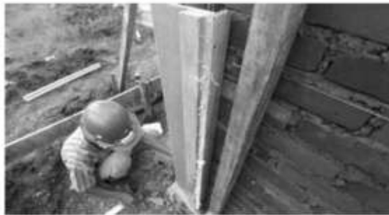
Gambar II.414 Pemasangan Cetakan/ Bekisting Untuk Kolom
