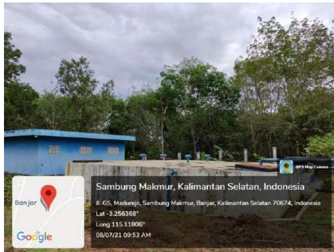
Gambar 3.34 Unit Reservoir IPA Sambung Makmur
