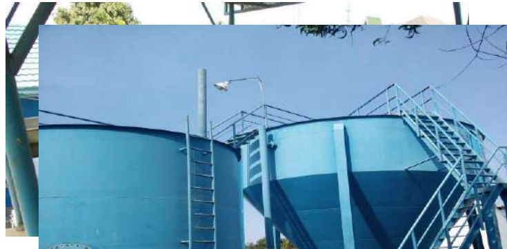
Gambar 3.18 IPA II WKE dengan kapasitas 20L/dt di Cabang II Kertak Hanyar
