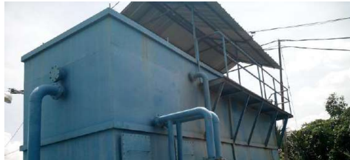
Gambar 3.15 IPA I PTN dengan kapasitas 15L/dt di Cabang II Sungai Tabuk
