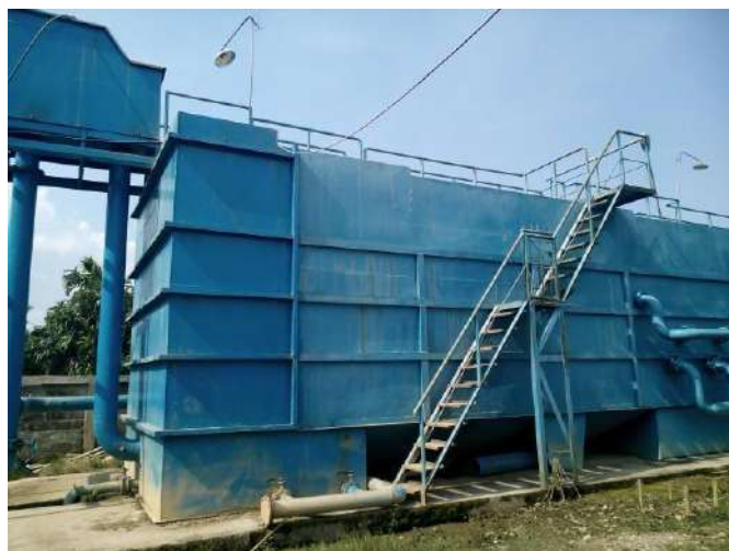
Gambar 3.17 IPA I Ruhak dengan kapasitas 50L/dt di Cabang II Kertak Hanyar
