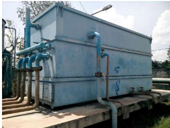
Gambar 3.16 IPA II Maswandi dengan kapasitas 5L/dt di Cabang II Sungai Tabuk
