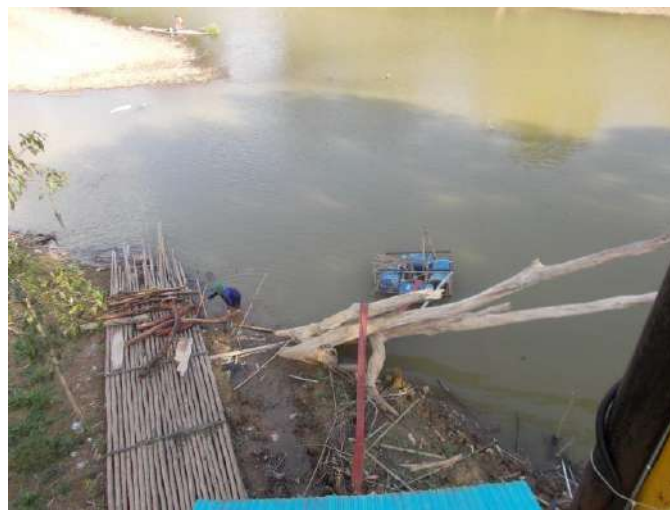
Gambar 3.9 Sungai Riam Kiwa dan Intake unit IKK Sungai Pinang
