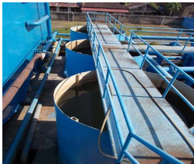
Gambar 3.14 Unit Koagulasi Flokulasi PDAM Intan Banjar
