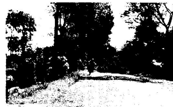
Foto Ruas Jalan Bandungan - Sumowono
