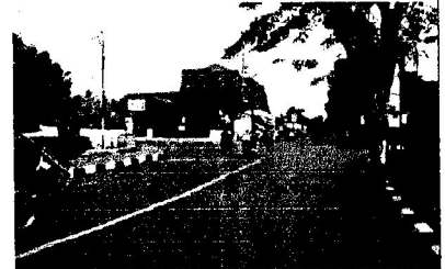
Foto Ruas Jalan A, Yani Kalirejo, Kec. Ungaran Timur
