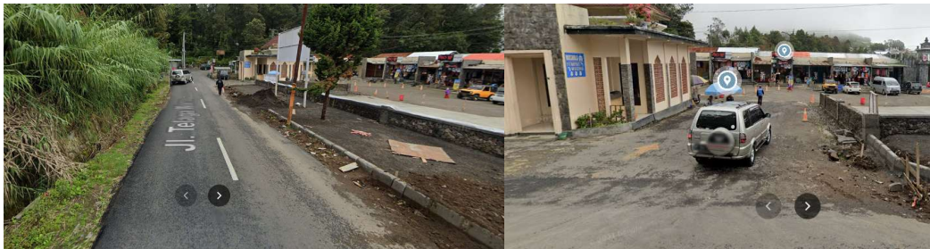
Gambar 2.42 Kondisi Jalan Utama dan Area Parkir Geosite Telaga Warna (Telogo Warno/Telogo Pengilon)
