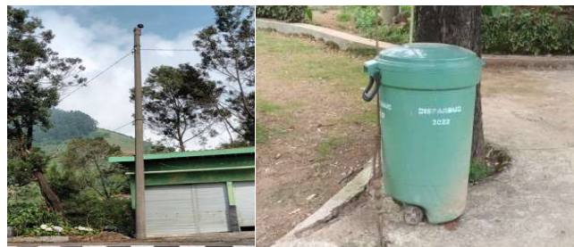
(a) Infrastruktur Energi Listrik
