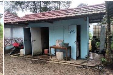
(b) Infrastruktur Air Bersih
