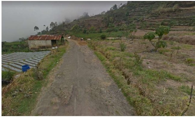
Gambar 2.14 Kondisi Jalan Utama Menuju Geosite Curug Sikarim Sumber: Google Street View (2023)
