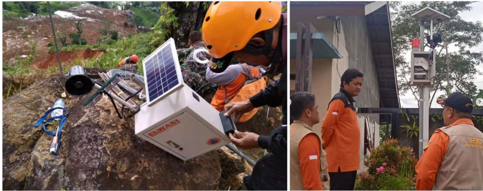
Gambar 1.61 Pemasangan Alat Peringatan Dini Gerakan Tanah Sebagai Upaya Mitigasi Tanah Longsor Sumber: BPBD Kab. Banjarnegara (2023)
