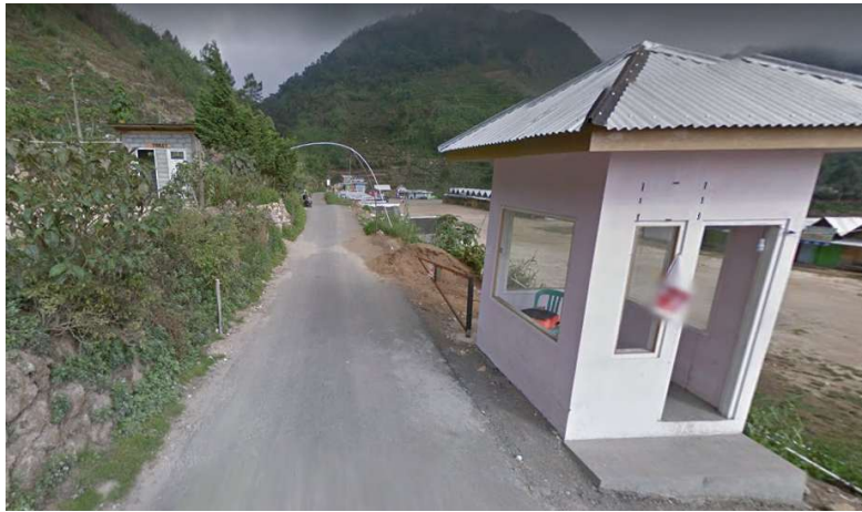
Gambar 2.29 Kondisi Jalan Utama Menuju Geosite Gunung Seroja Sumber: Google Street View (2023)
