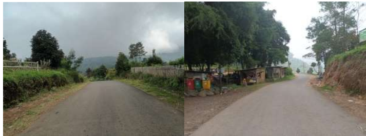
Gambar 2.103 Kondisi Jalan Utama dan Jalan Menuju Geosite Telaga Dringo
