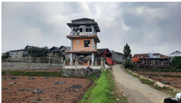
Gambar 2.125 Kondisi Fasilitas Gardu Pos Pengamatan Kawah Timbang
