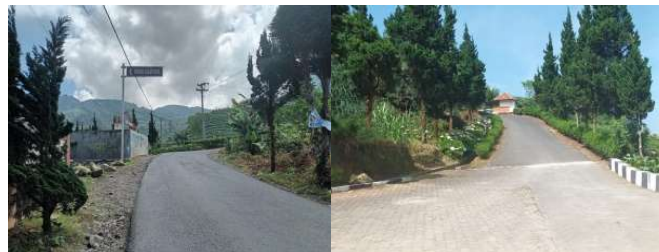
Gambar 2.115 Kondisi Jalan Utama dan Jalan Menuju Geosite Sumur Jalatunda
