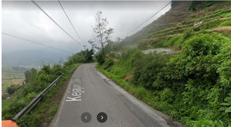
Gambar 2.33 Kondisi Jalan Utama Menuju Geosite Gunung Prambanan Sumber: Google Street View (2023)
