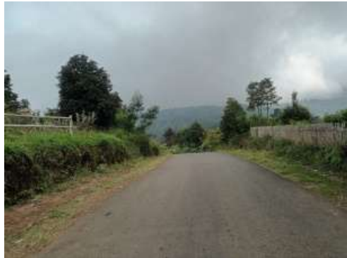
Gambar 2.111 Kondisi Jalan Utama Menuju Geosite Kawah Sinila
