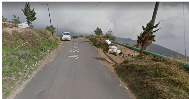
Gambar 2.37 Kondisi Jalan Utama Menuju Geosite Lava Gunung Pakuwaja Sumber: Google Street View (2023)
