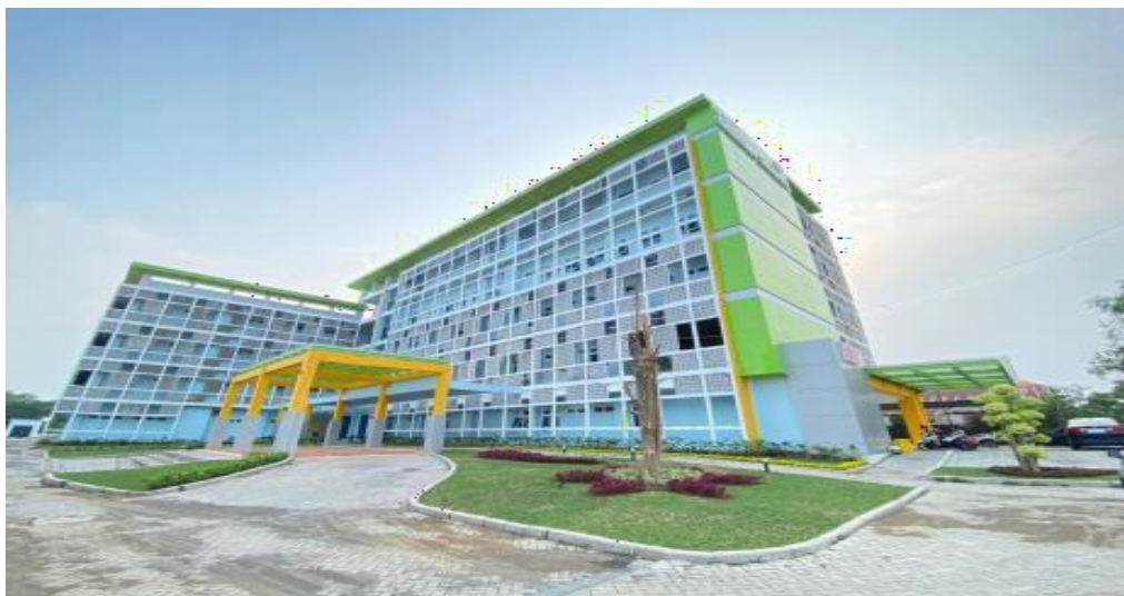
Gambar 2.1 Gedung RSUD Gresik Sehati Kabupaten Gresik
