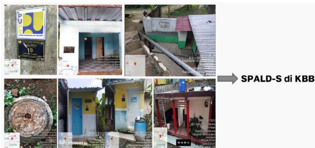
Gambar 3.17 Kondisi SPALD-S di KBB
