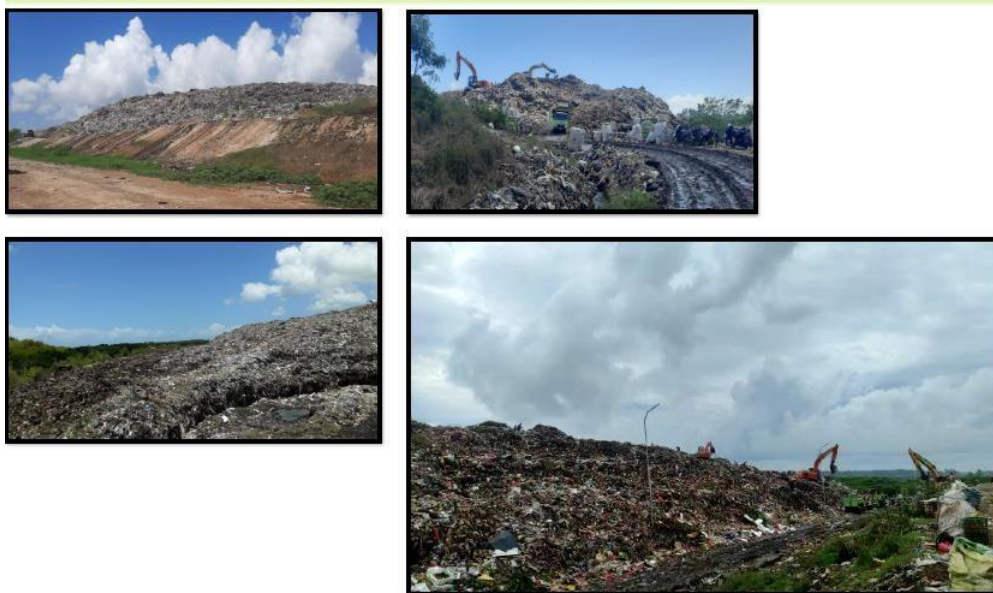
Gambar 3.27 Kondisi Eksisting TPA Suwung (Lanjutan) Sumber: Dokumentasi Konsultan
