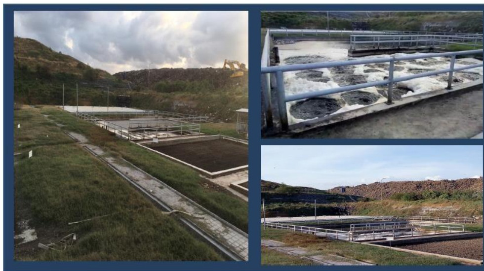
Gambar 3.27 Kondisi Eksisting TPA Suwung (Lanjutan) Sumber: Dokumentasi Konsultan
