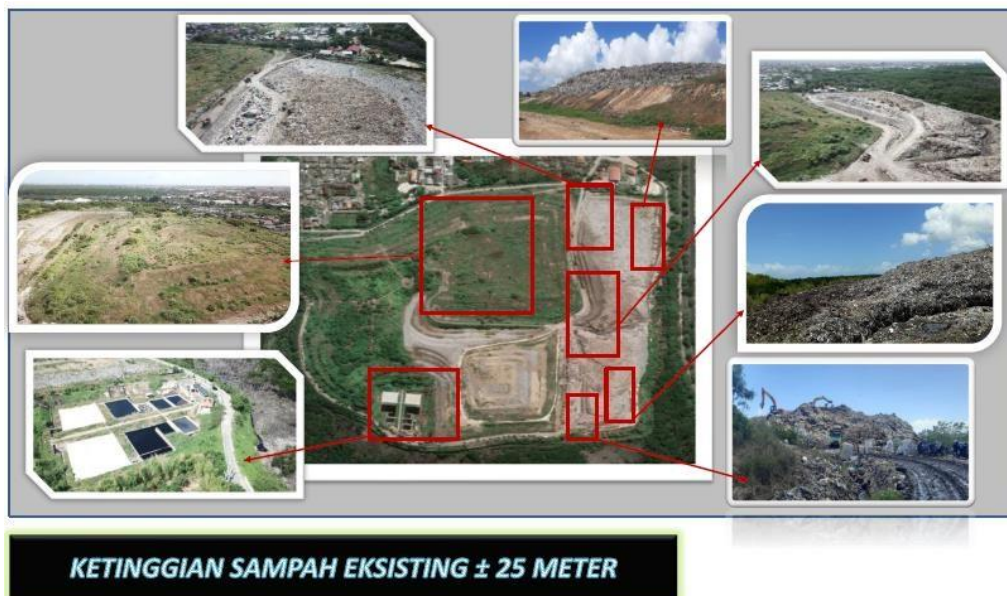
Gambar 3.27 Kondisi Eksisting TPA Suwung Sumber: Dokumentasi Konsultan
