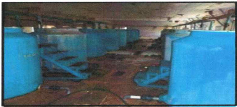
Gambar 3.29 Tangki Pelarutan Kimia
