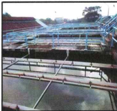
Gambar 3.27 Bak Sedimentasi HK
