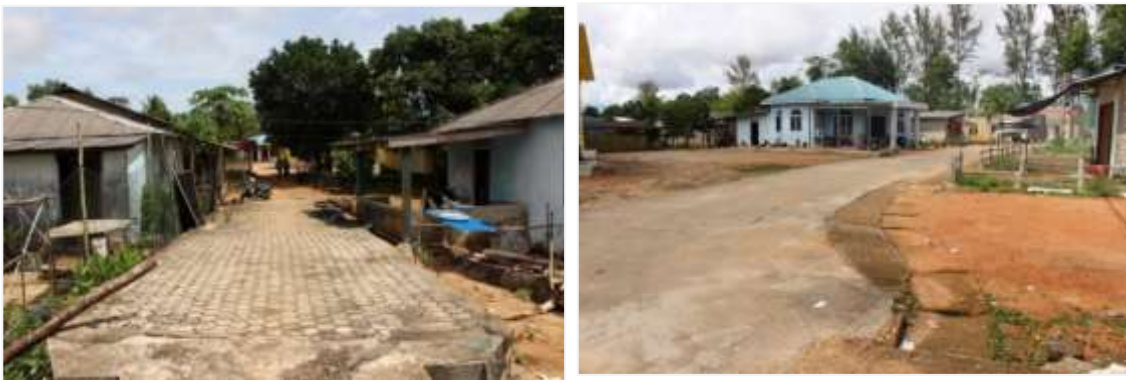
Gambar 2. Kondisi Bangunan Gedung di Kampung Madong – Sei Nyirih
