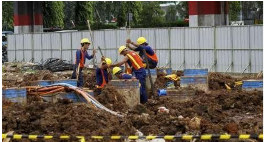
Gambar 8. 4. Penggantian Pipa Transmisi
