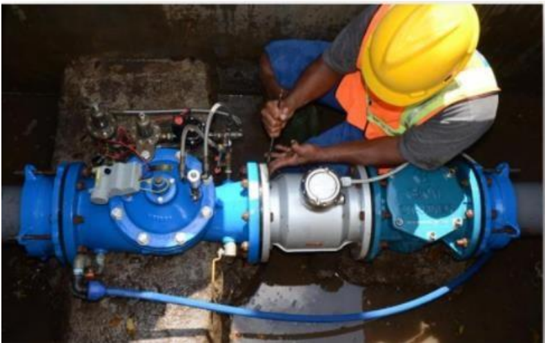
Gambar 8. 9. Rangkaian DMA
